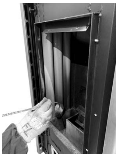
Fig. 72 - Wyczyścić szczotką do rur
