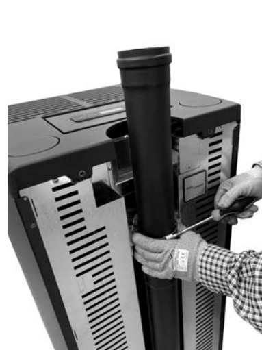
Fig. 41 - Zamontowany tylny wylot dymu
