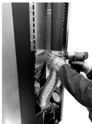
Fig. 53 - Przymocować rury
