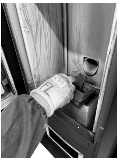
Fig. 61 - Usunąć ruszt paleniskowy
