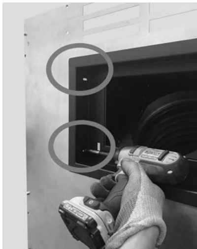
Fig. 66 - Mocowanie zewnętrzne kłapy
