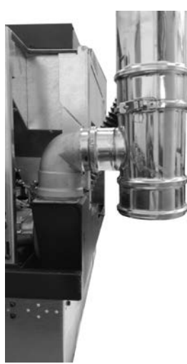
Fig. 76 - Połączenie rury koncentrycznej
