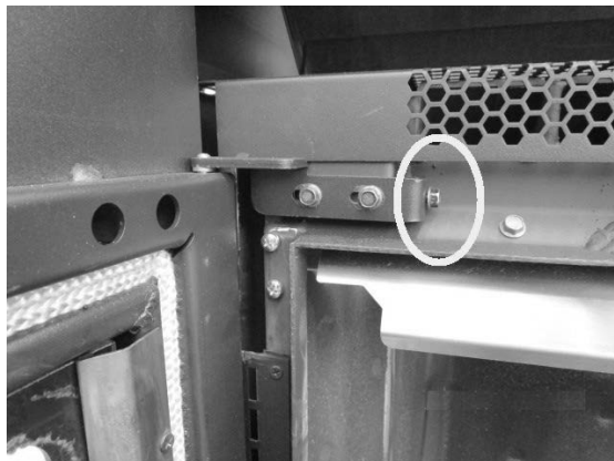
Fig. 26 - Regulacja drzwi
