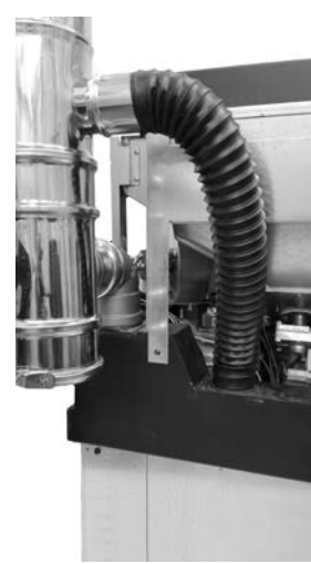
Fig. 77 - Połączenie przewodu powietrza do spalania
