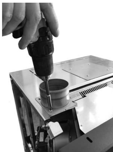
Fig. 47 - Umocować złączkę
