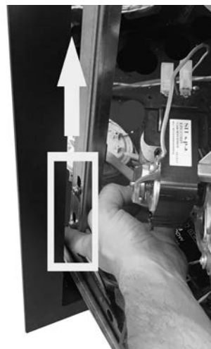
Fig. 21 - Podnieść płytkę blokującą.
