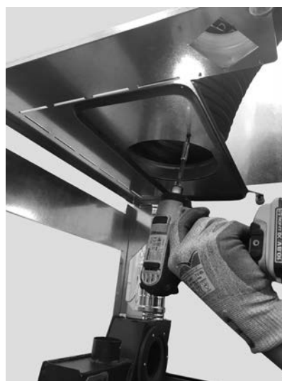
Fig. 65 - Mocowanie węża.
