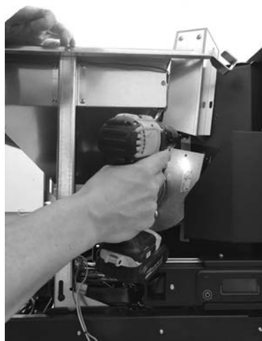
Fig. 44 - Umocować wentylator
