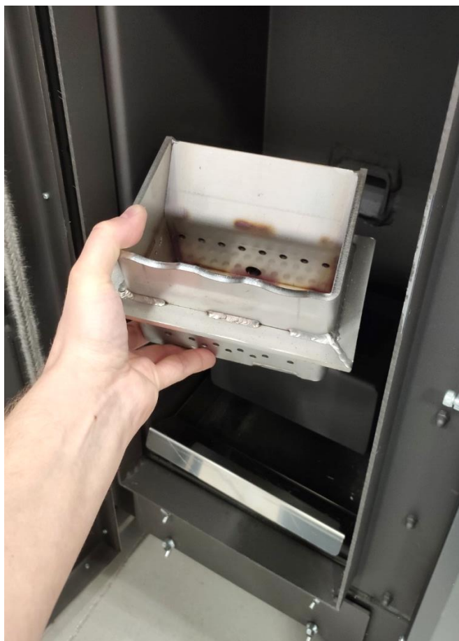
Czyszczenie rusztu w piecyku
